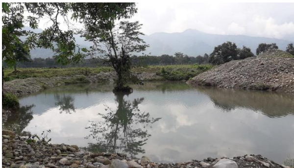
Wasserreservoir Projekt mit unserem Tee-Partner TPI in Indien
